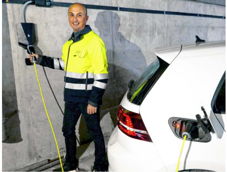
IDK René Burkard, Leiter Technischer Kundendienst/Installation.
