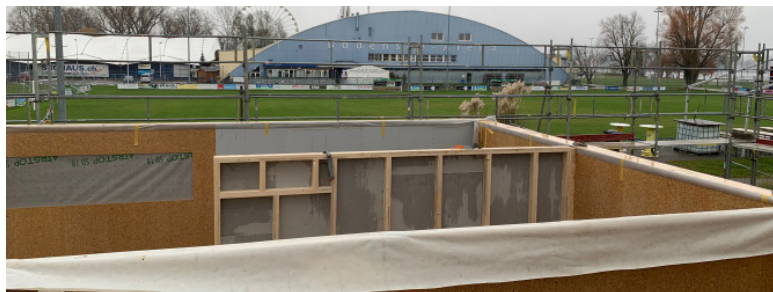
Die vorgefertigten Bauteile hievt der Kran direkt auf die Baustelle, wo sie von Zimmermannsleuten montiert werden. Bild: IDK
